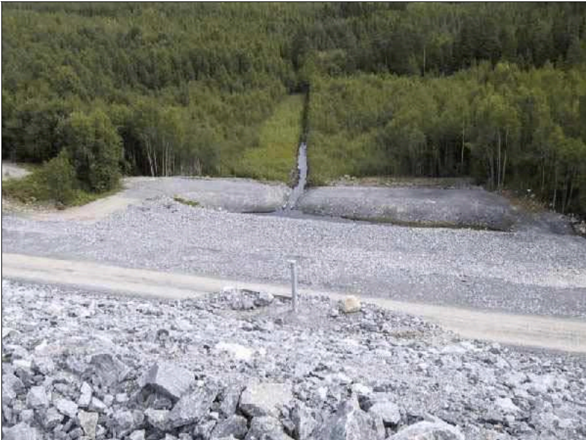
Obrázok 14. Ďalšia priekopa pre zber a meranie prietoku priesakov pozdĺž hrádze [66, BASE METALS GROUP, 2002]
